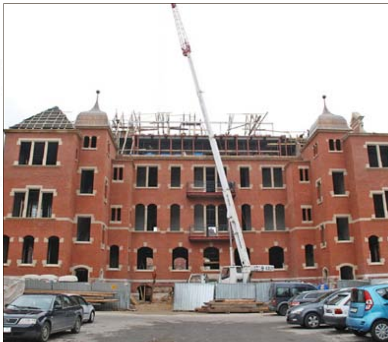
Die Renovierungsarbeiten an der ehemaligen Eisenbahndirektion Danzig, in der sich künftig eine Brauerei befinden soll, gehen mit Volldampf voran Foto: Rafał Reclaw
