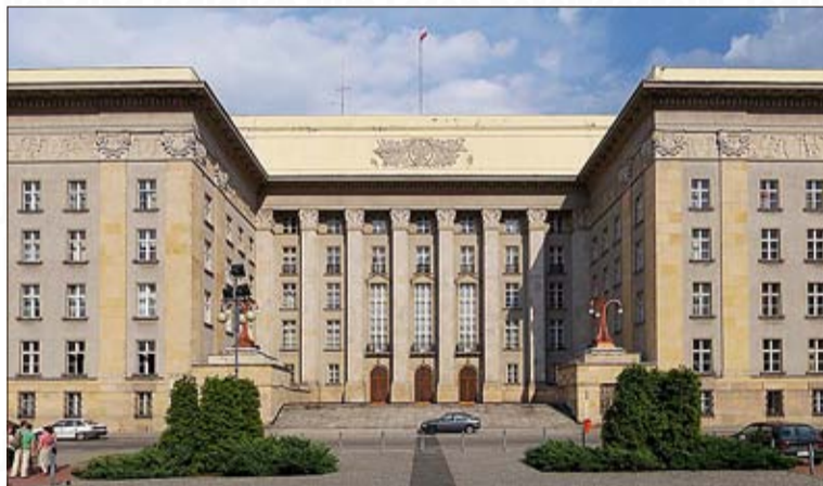
Das Gebäude des Sejmik der Woiwodschaft Schlesien in Katowice
